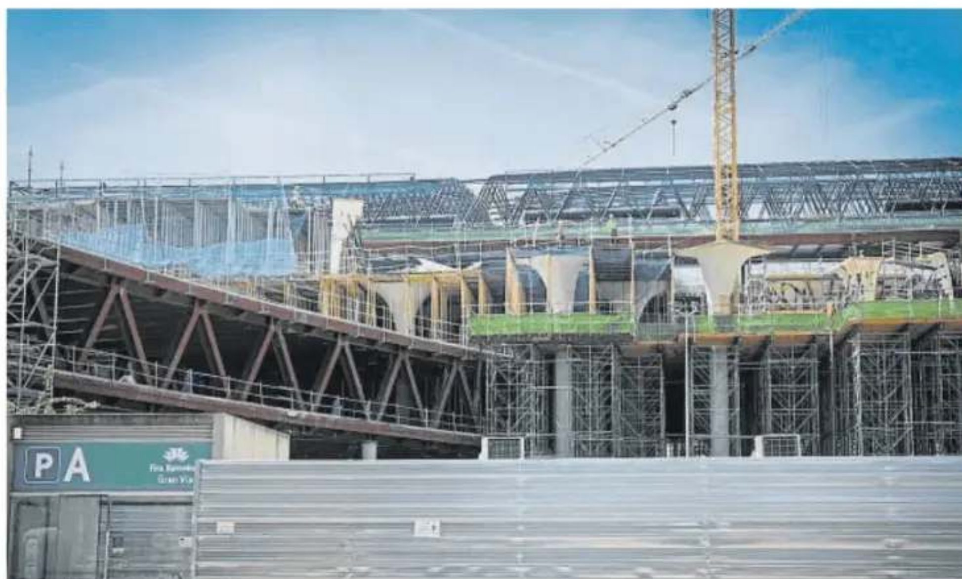
La estructura roja es el puente elevado, y las columnas, con forma de palmera, sostendrán el techo
