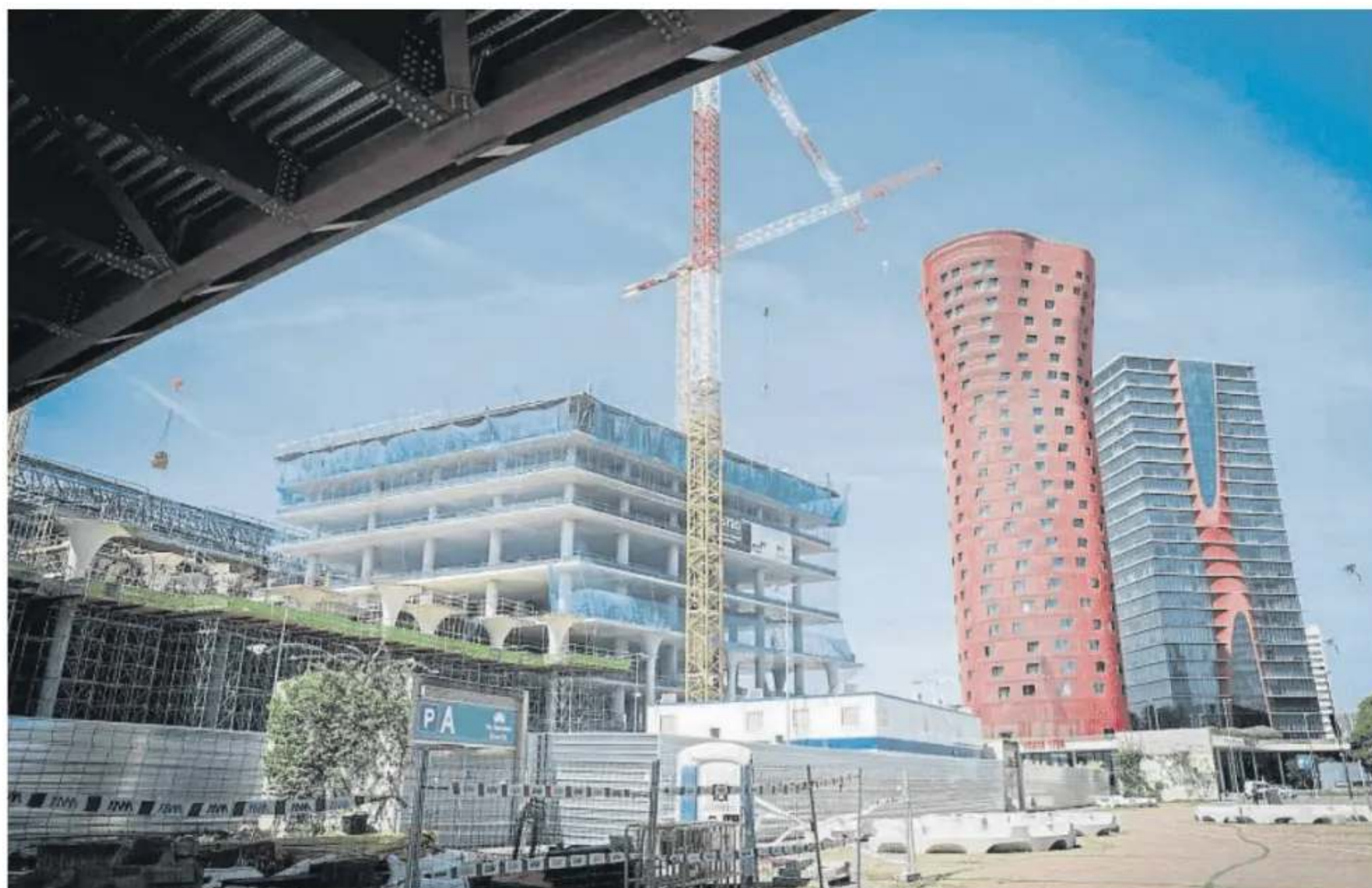
El futuro pabellón y la pasarela elevada que lo conecta con el resto del recinto ferial ya toman forma junto a la plaza Europa
